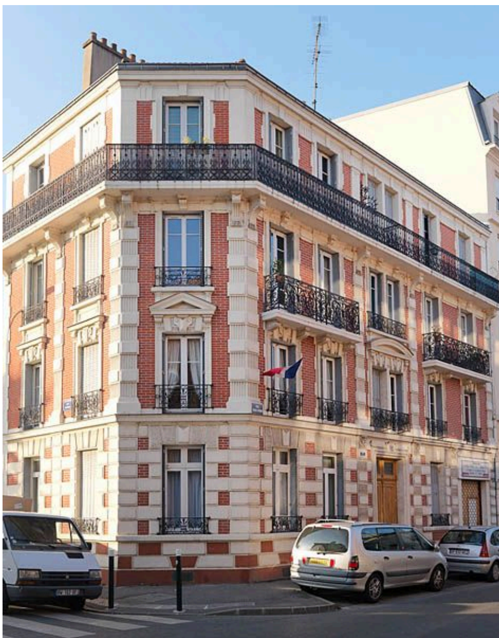
Alfortville, immeuble, 34 rue Vaillant Couturier. Vue générale.
