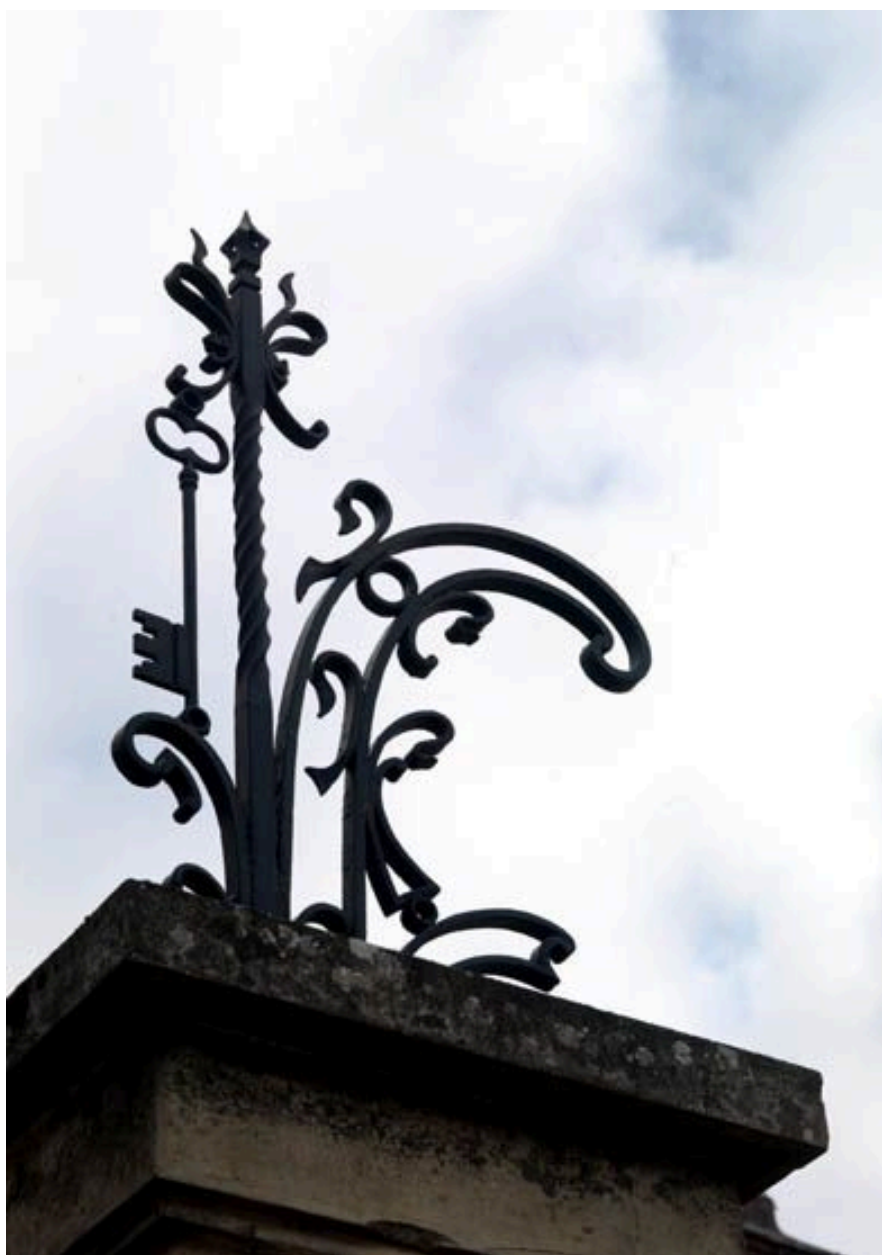
Portail d'entrée, vue de détail de la ferronnerie.
