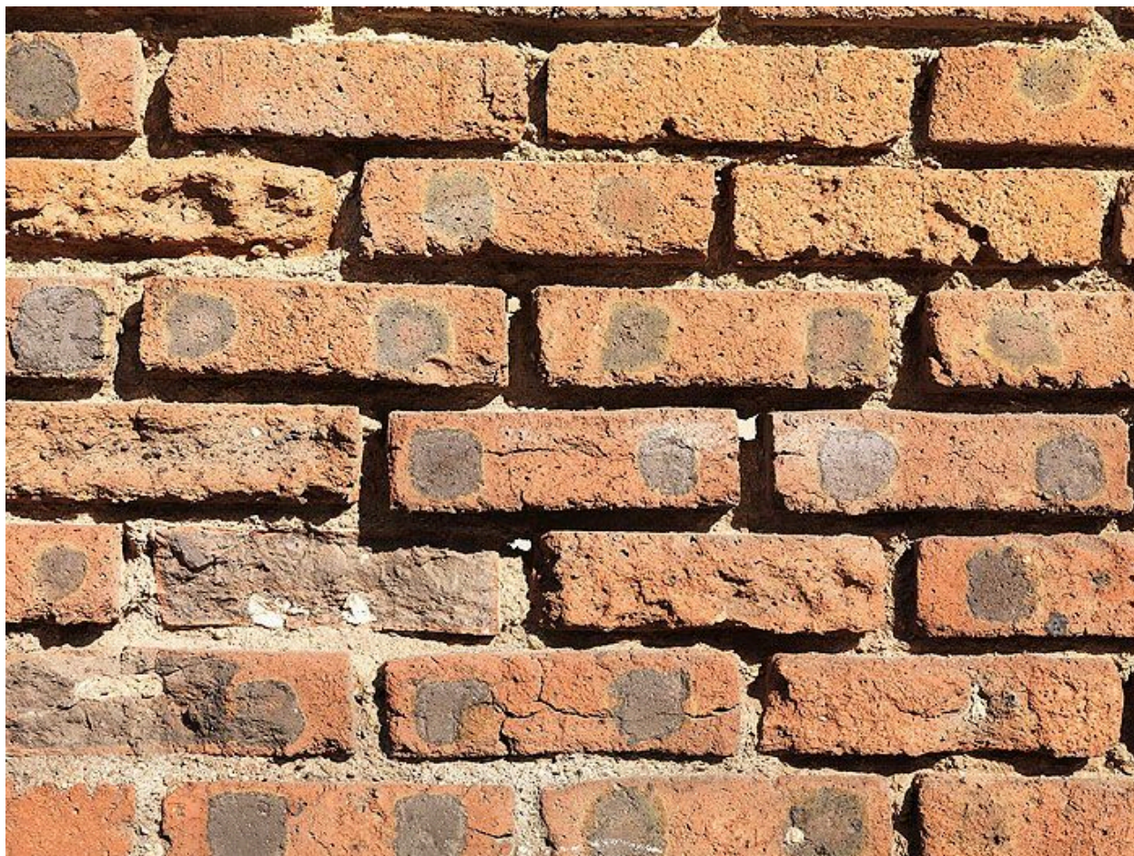
93, Bagnolet, église paroissiale Notre-Dame-de-Pontmain, rue Robespierre. Détail de l'appareil de brique ordinaire du mur de clôture de l'enceinte paroissiale.
