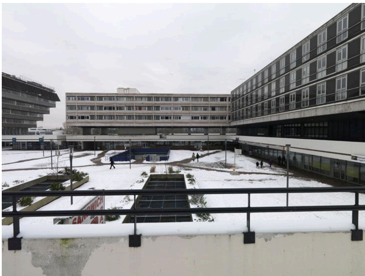
Vue d'ensemble des deux bâtiments et du parvis de la Préfecture
