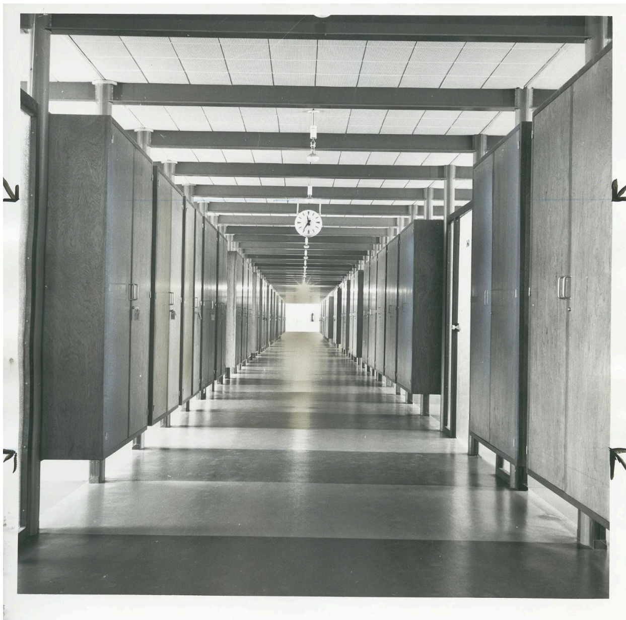
1961, le siège d'Air France ou bâtiment 363
