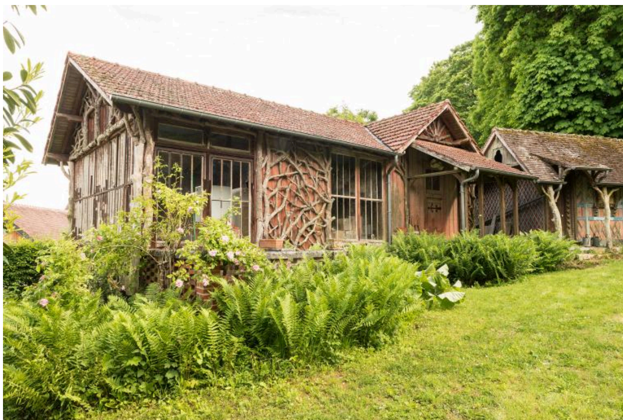
Vue générale des ateliers (7)
