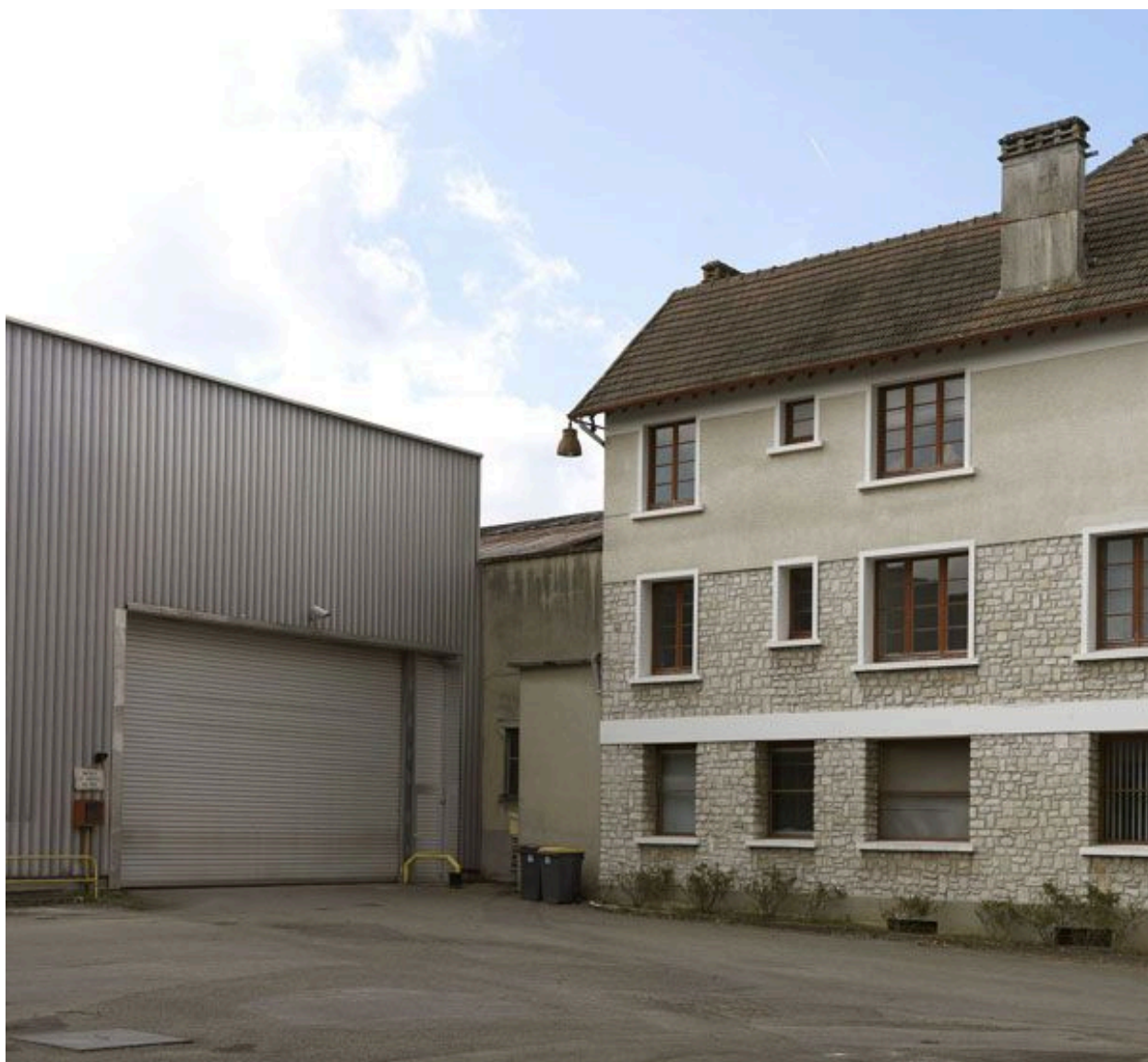
Aile arrière du bâtiment administratif communiquant avec les ateliers.
