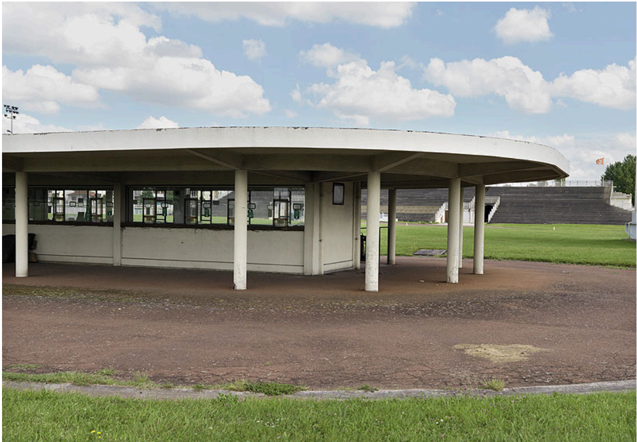
Détail de l'architecture des guichets au centre du champ de course.
