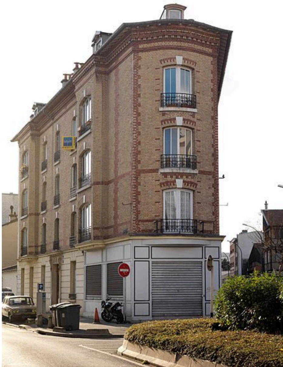
Ivry-sur-Seine, immeuble, 2 rue Pierre Galais, rue Edmée Guillou. Vue d'ensemble.
