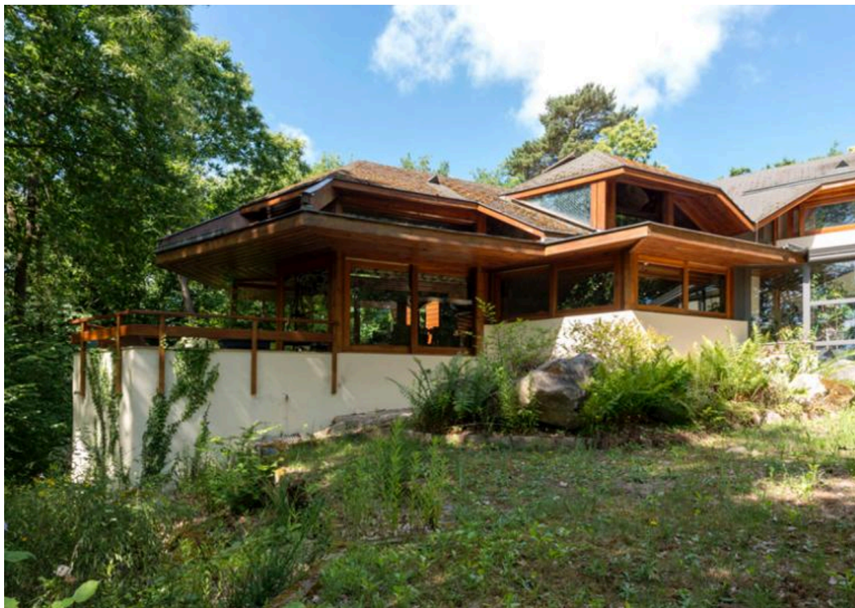
Vue partielle de la façade : détail de l'aile gauche.
