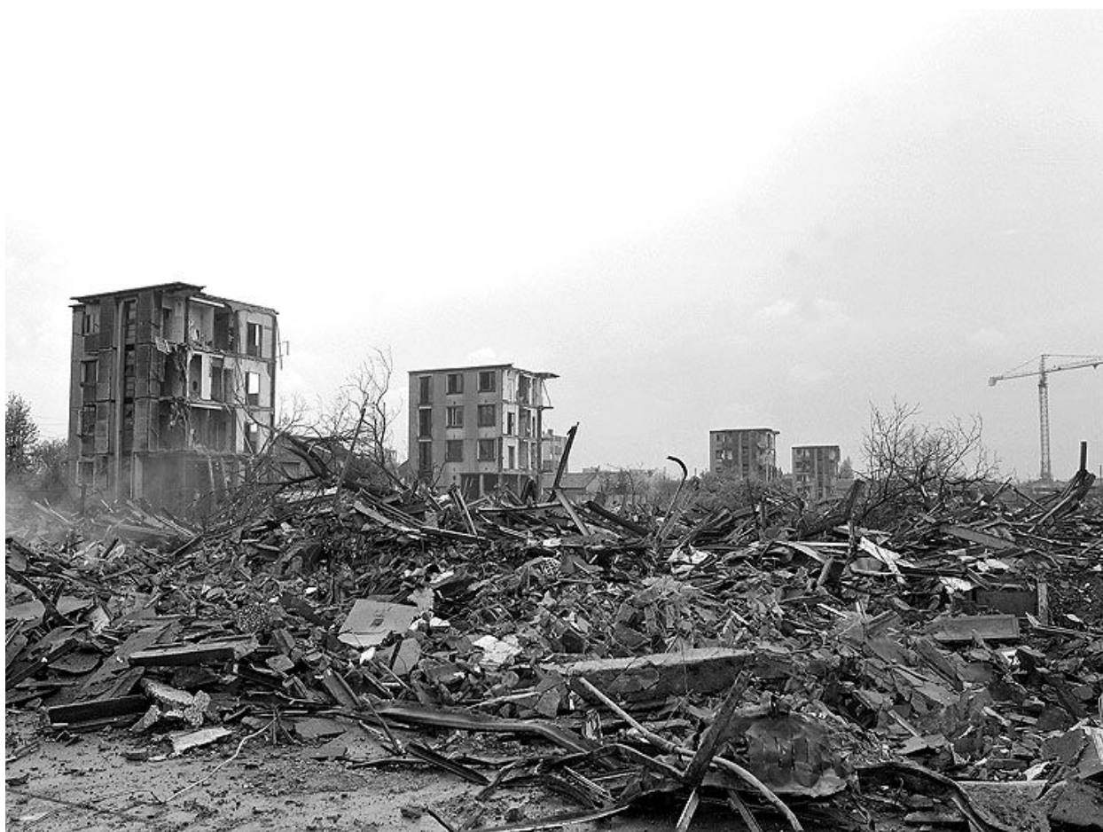
Ensemble des peignes restants P10, P9, P6 et P5. Campagne photographique, lors de la destruction du bâtiment en 1976.
