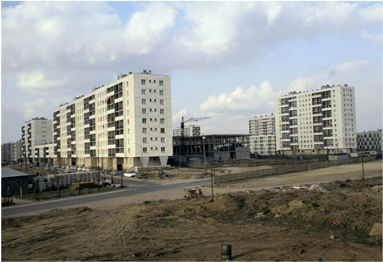
Le chantier de construction des barres F, G, H et J depuis l'avenue du Noyer Lambert. Photographie, 1965. (Ministère de l'Ecologie, STU00336)
