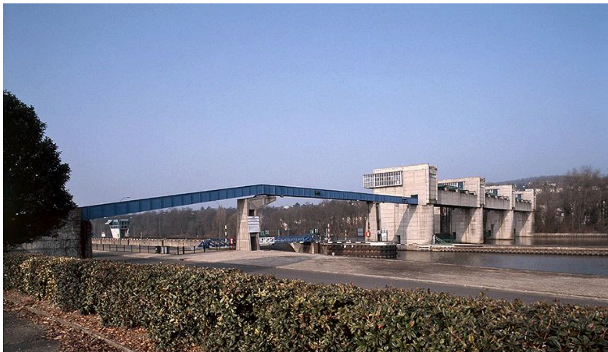
Vue d'ensemble du barrage et des écluses.
