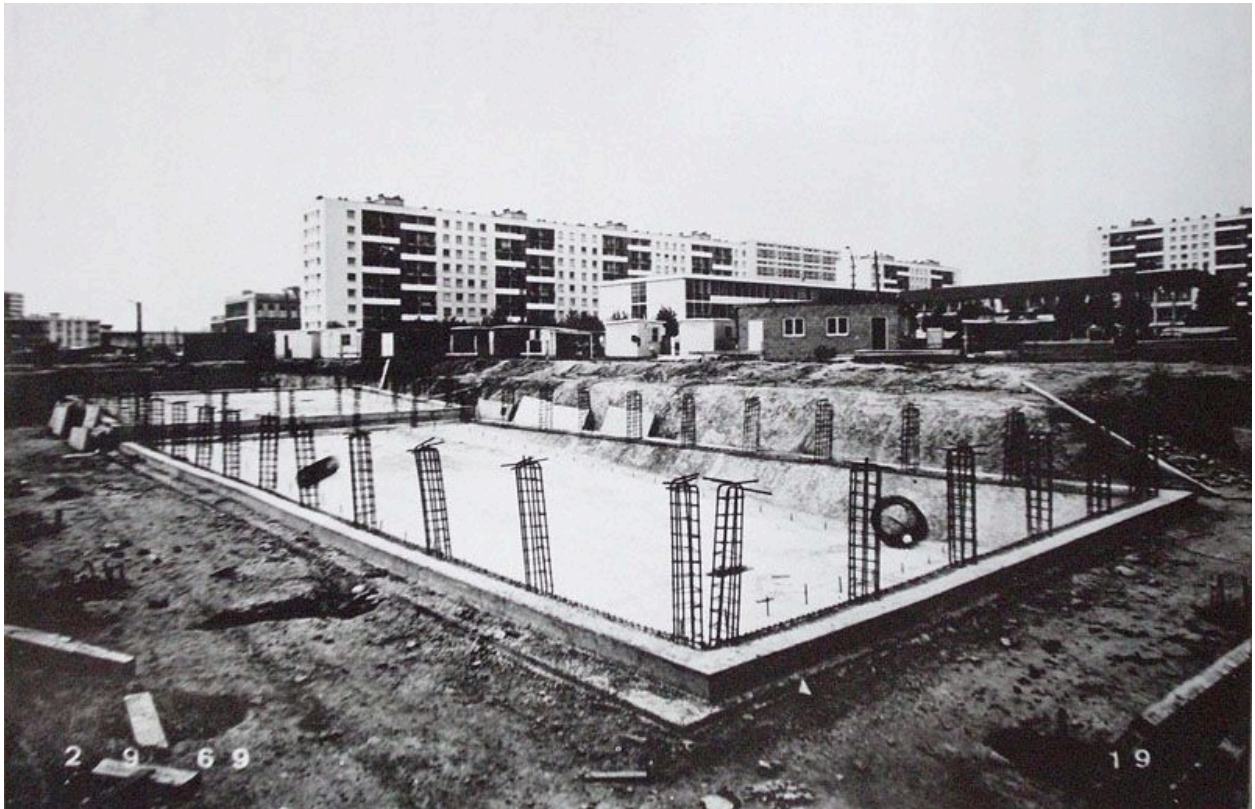
Vue du chantier de construction: la piscine. Photographie. (Association des Amis du Vieux Massy)
