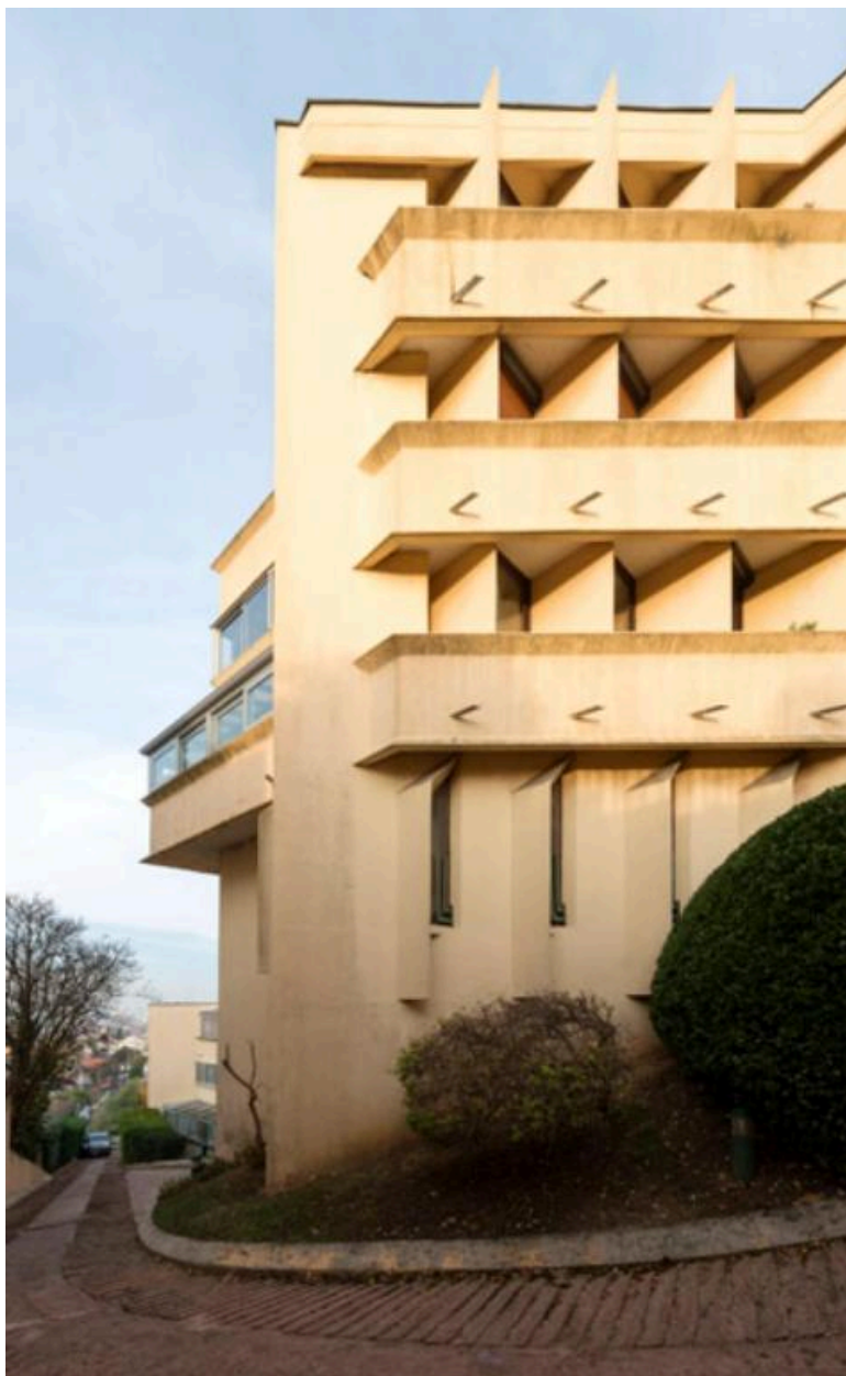
Vue latérale de l'immeuble (prise du côté gauche).
