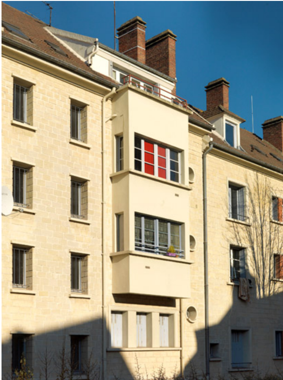
Un bow-window sur la façade arrière de l'îlot D.
