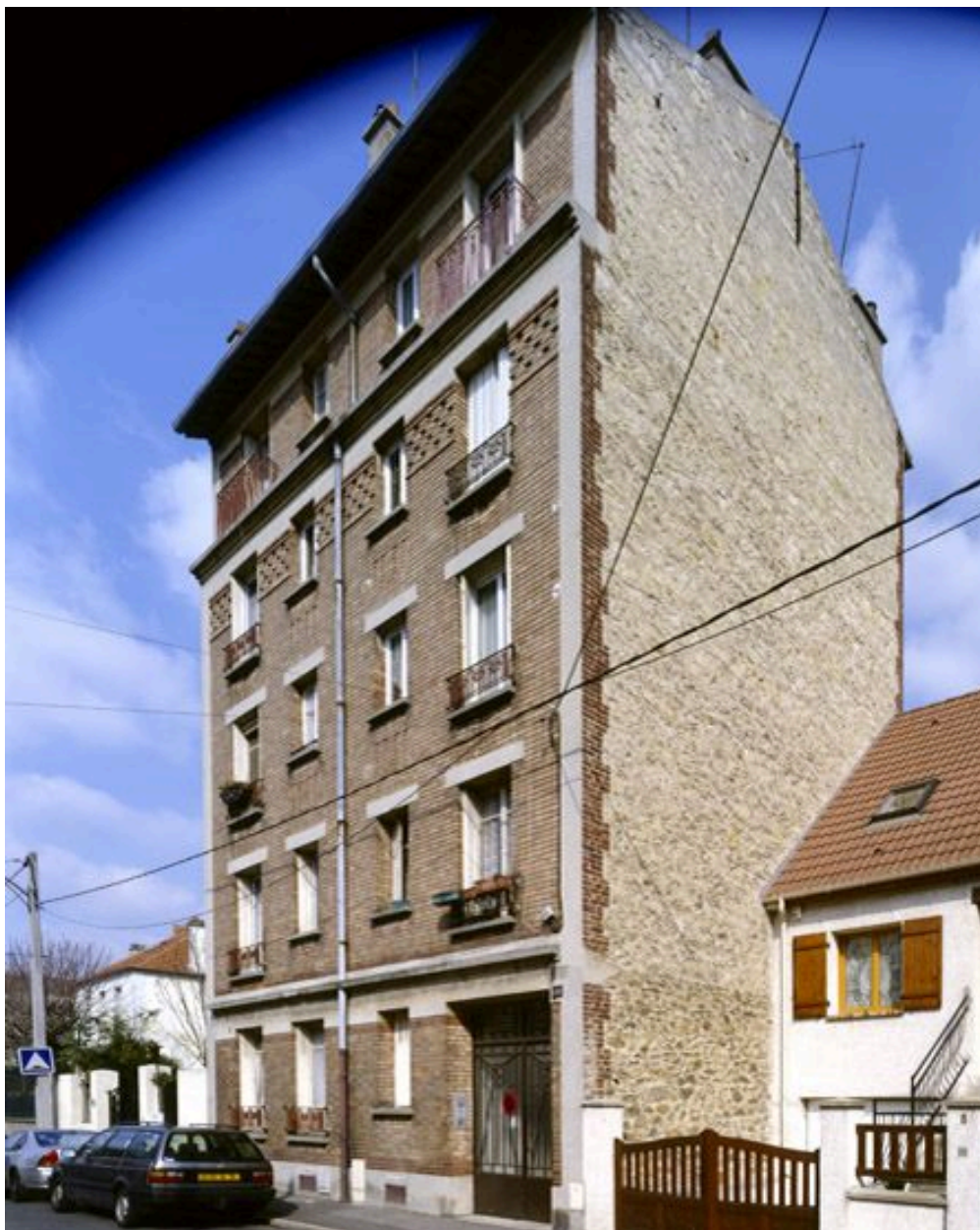
Immeuble, 10 rue des Frères-Petit. Vue d'ensemble de l'immeuble signé de l'architecte campinois H. Bataille et de l'entrepreneur installé à Champigny F. Quagliaroli.
