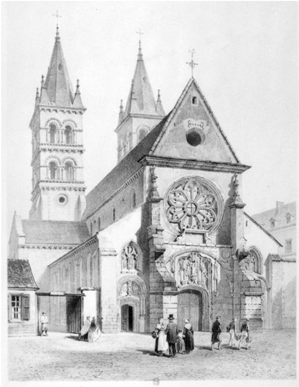
Façade de l'église Notre-Dame après la reconstruction de l'abside et des deux tours par M. Eug. Millet, architecte diocésain. Lithographie, 1858. Tiré de : Les monuments de Seine-et-Marne / Aufauvre et Fichot. Paris, 1858. (BNF, Département des estampes. Topo Va Seine-et-Marne)
