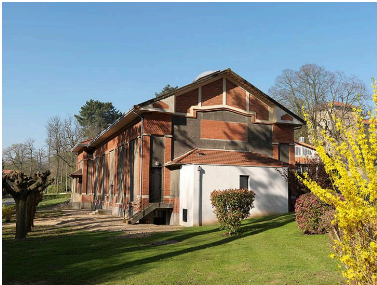
Bâtiment abritant le théâtre du sanatorium, élévation postérieure, vue générale.
