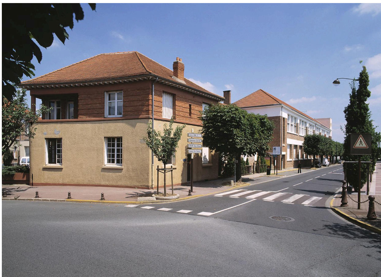
Vue de l'aile droite des bâtiments le long de l'avenue Paul-Vaillant-Couturier.
