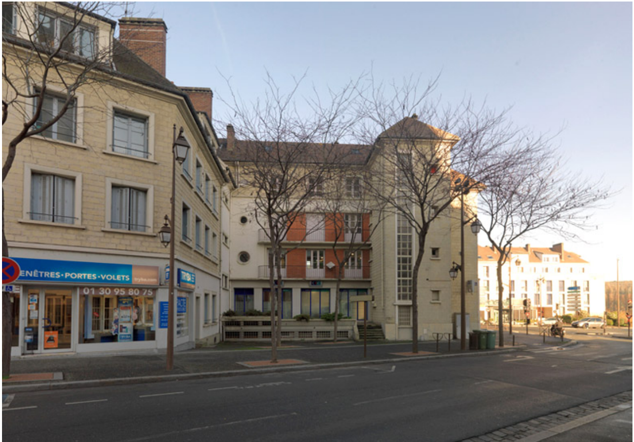
La façade arrière de l'immeuble traversant de l'îlot D.
