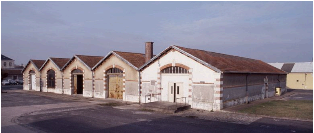
Le quartier Pajol : hangars au nord du bâtiment de l'état-major.
