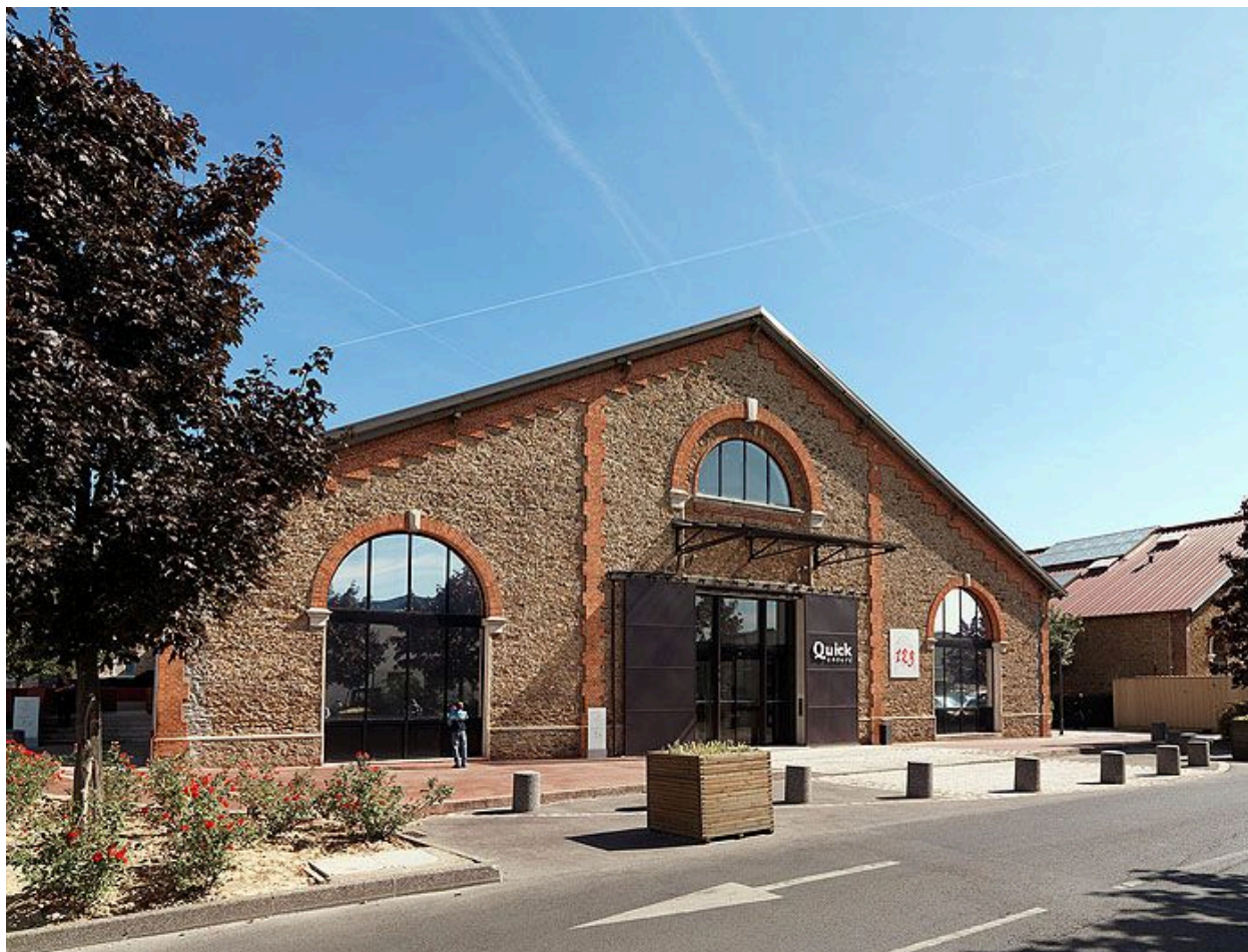
93, Saint-Denis, entrepôt commercial de la Compagnie des Entrepôts et Magasins généraux, 50 avenue Président-Wilson. Vue d'ensemble du pignon à larges baies cintrées de l'entrepôt de meulière.
