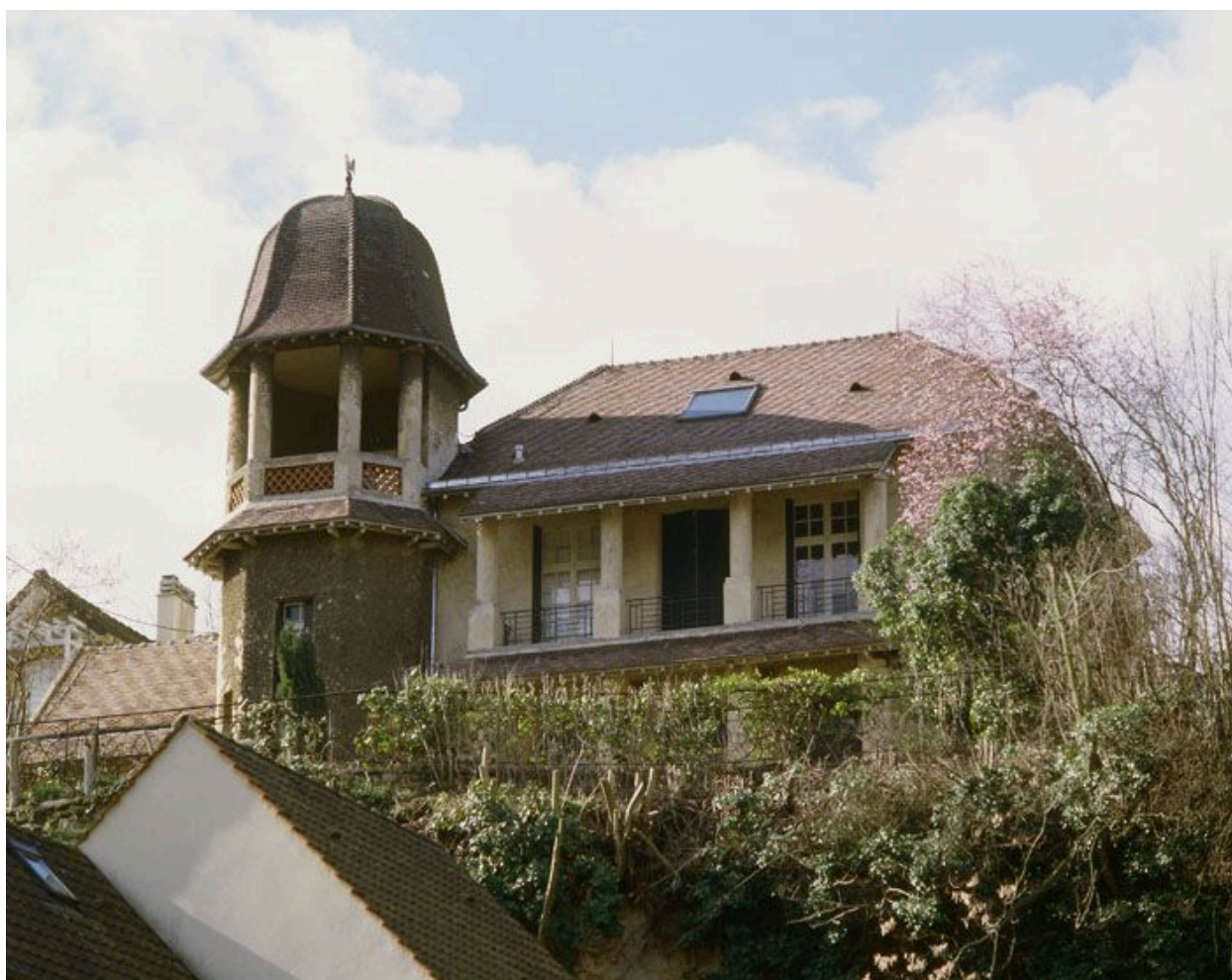
Vue d'ensemble de la façade panoramique.
