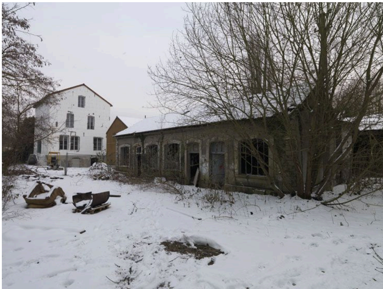
Follainville-Dennemont, cimenterie E. Candlot et Cie, puis A. Ladvocat et Cie , 44 rue Emile-Zola et rue Voltaire. Bâtiment administratif d'entreprise et atelier de réparation.
