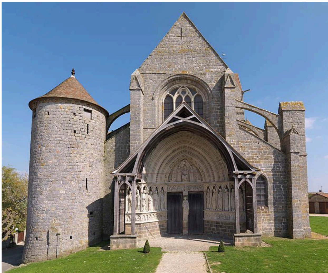
La façade occidentale, vue de face.
