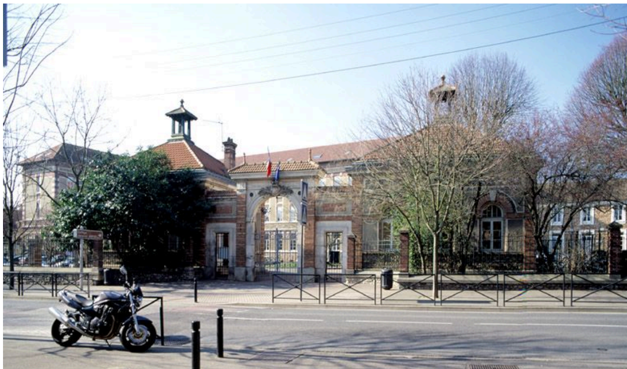
Vue générale, depuis la rue du Général-de-Gaulle.
