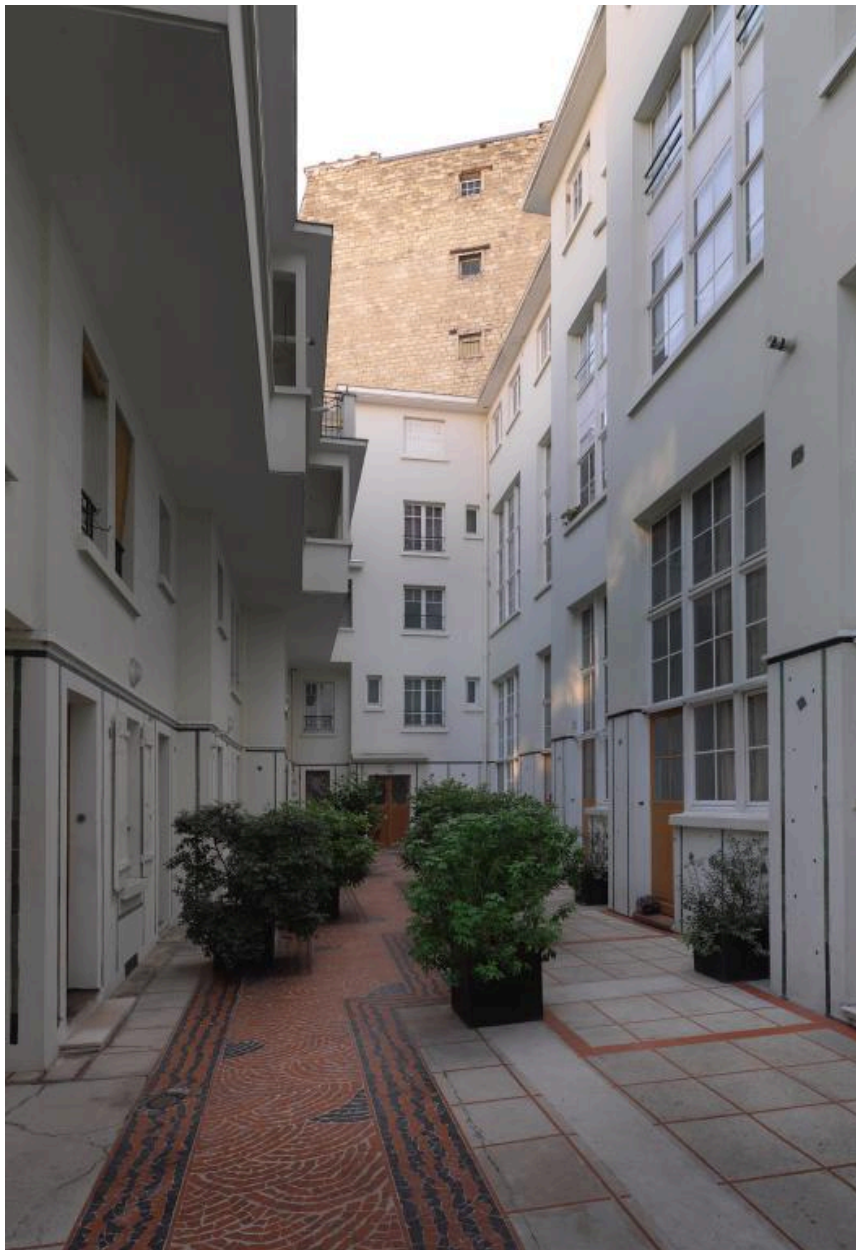
Vue de la cour entre le bâtiment C et le bâtiment D
