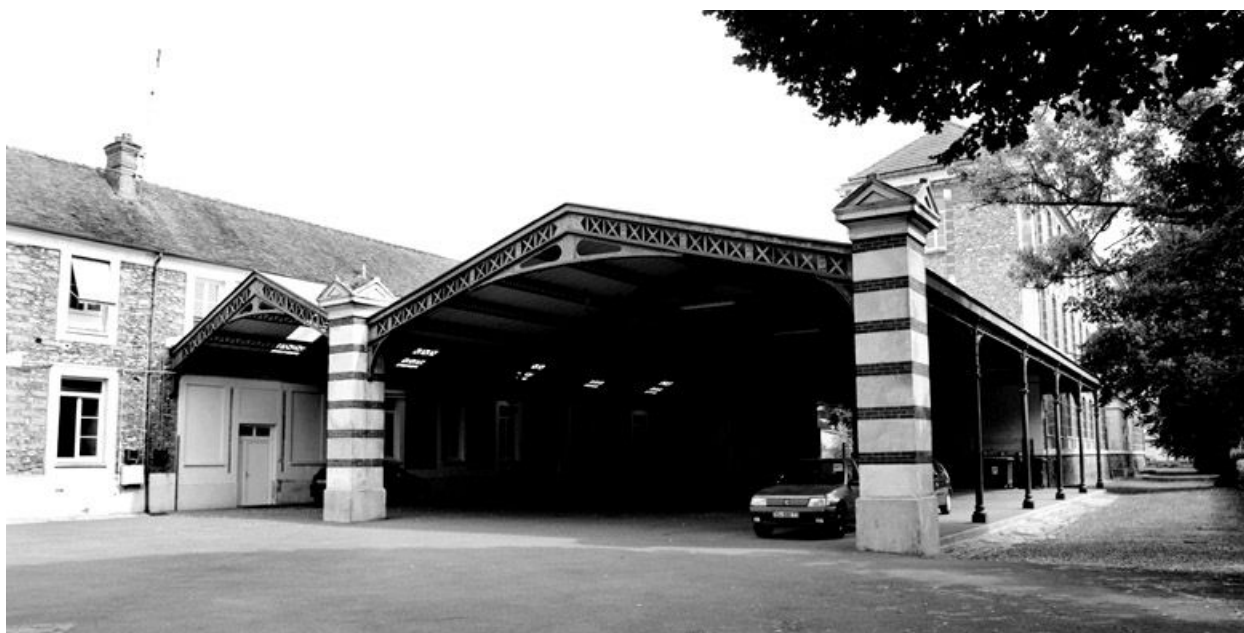
Vue d'ensemble du préau, depuis le sud-est.
