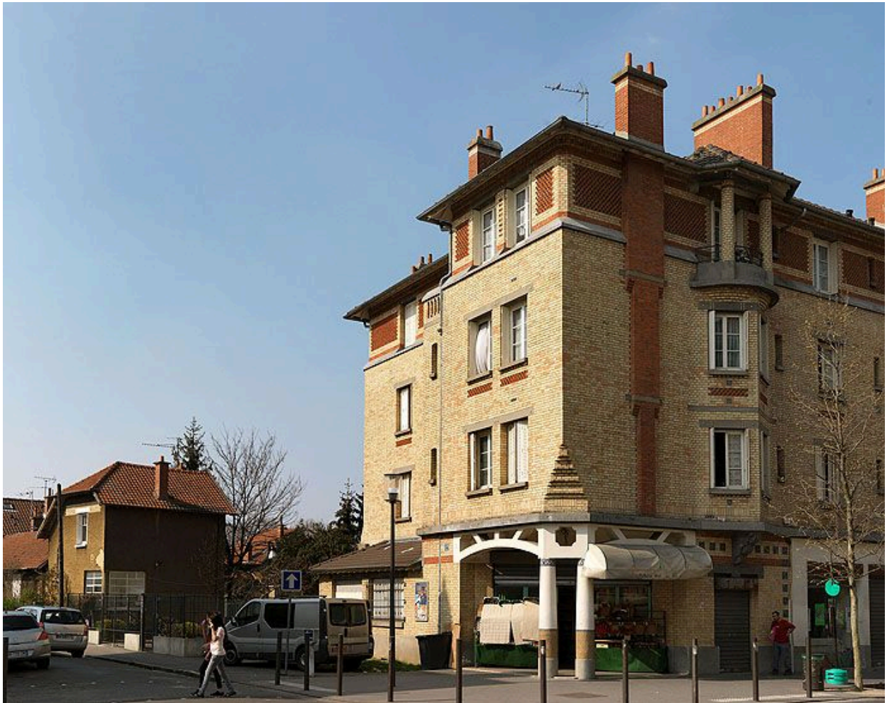
93, Stains, immeuble, avenue de la Division-Leclerc. Traitement de l'angle d'un immeuble de l'avenue avec encorbellement et pan coupé.
