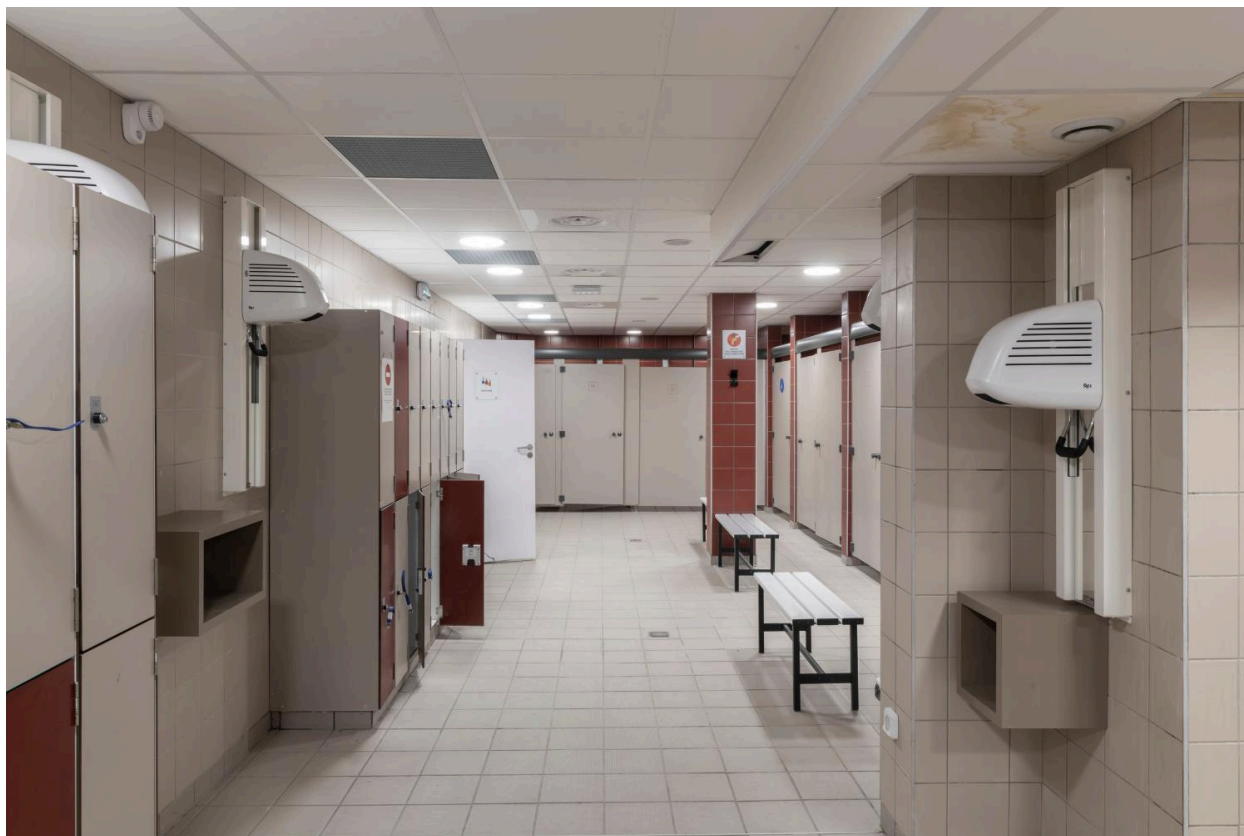
Vue intérieure des vestiaires et des douches, premier sous-sol
