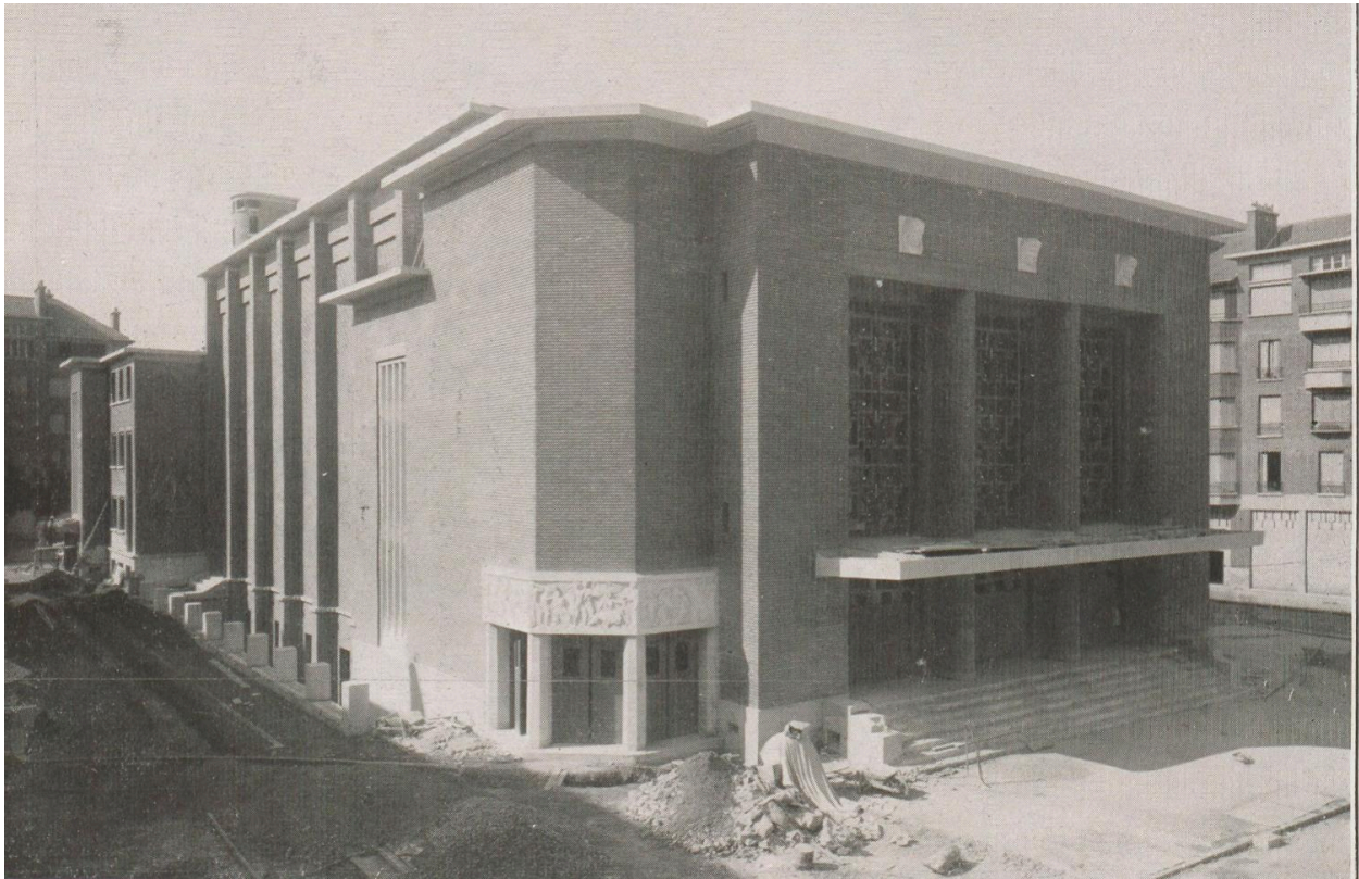
Vue du théâtre en construction. L'âge du ciment, bulletin technique des chaux et ciments de Lafarge et Du Teil ( janvier 1938)
