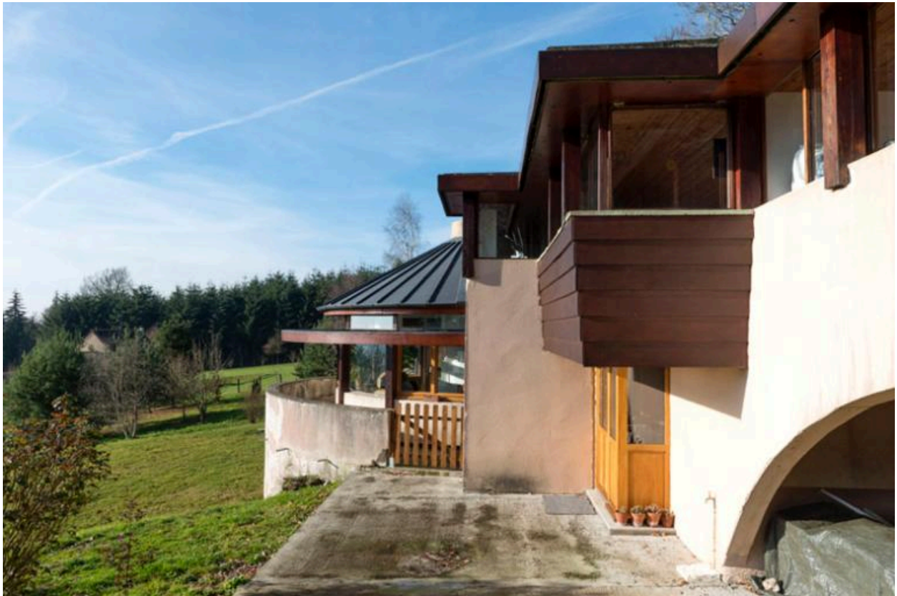
Vue latérale de la façade et de l'arche de soutènement.
