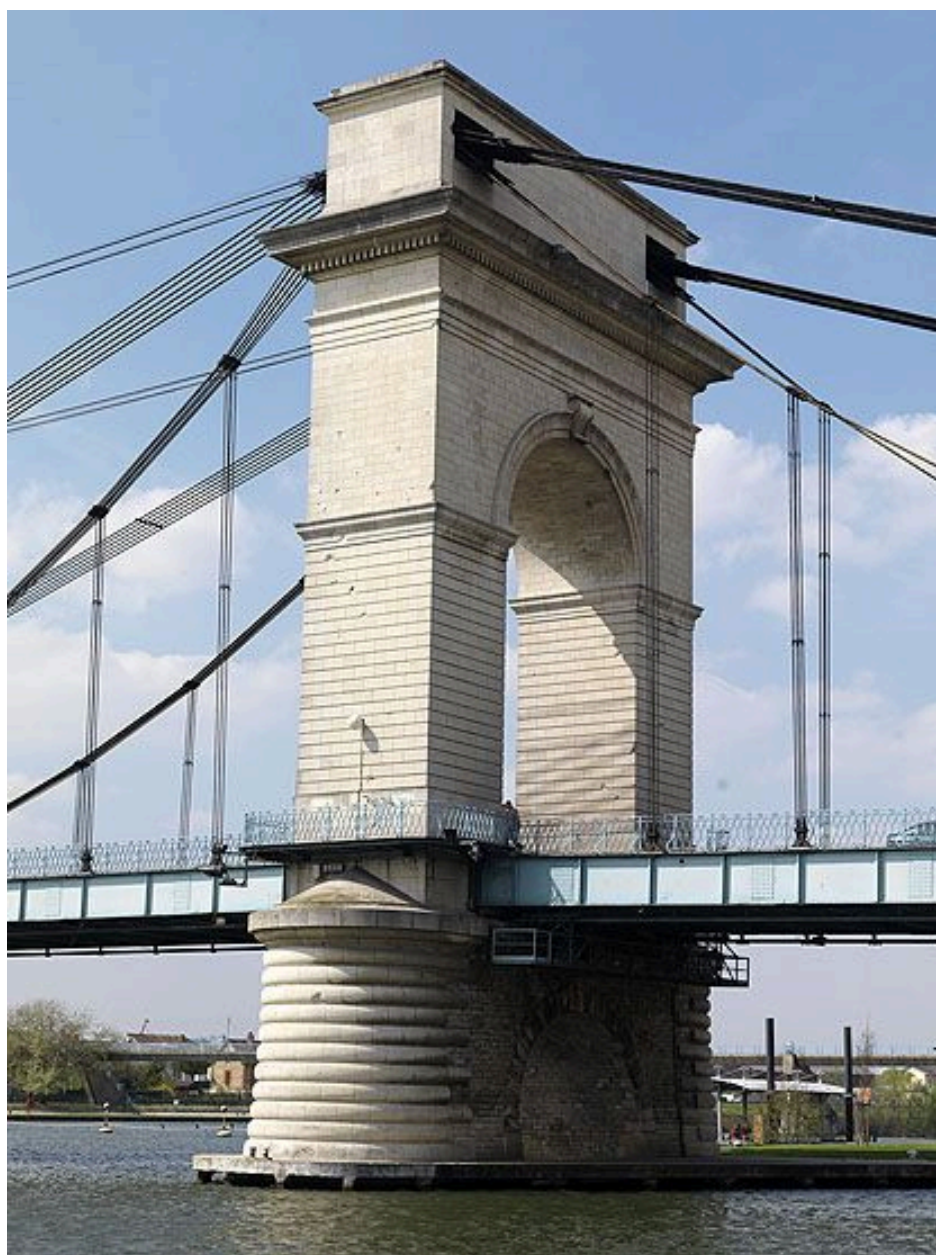
Vitry-sur-Seine, Alfortville. Pont de Port-à-l'Anglais. Vue d'ensemble de la pile côté Alfortville.
