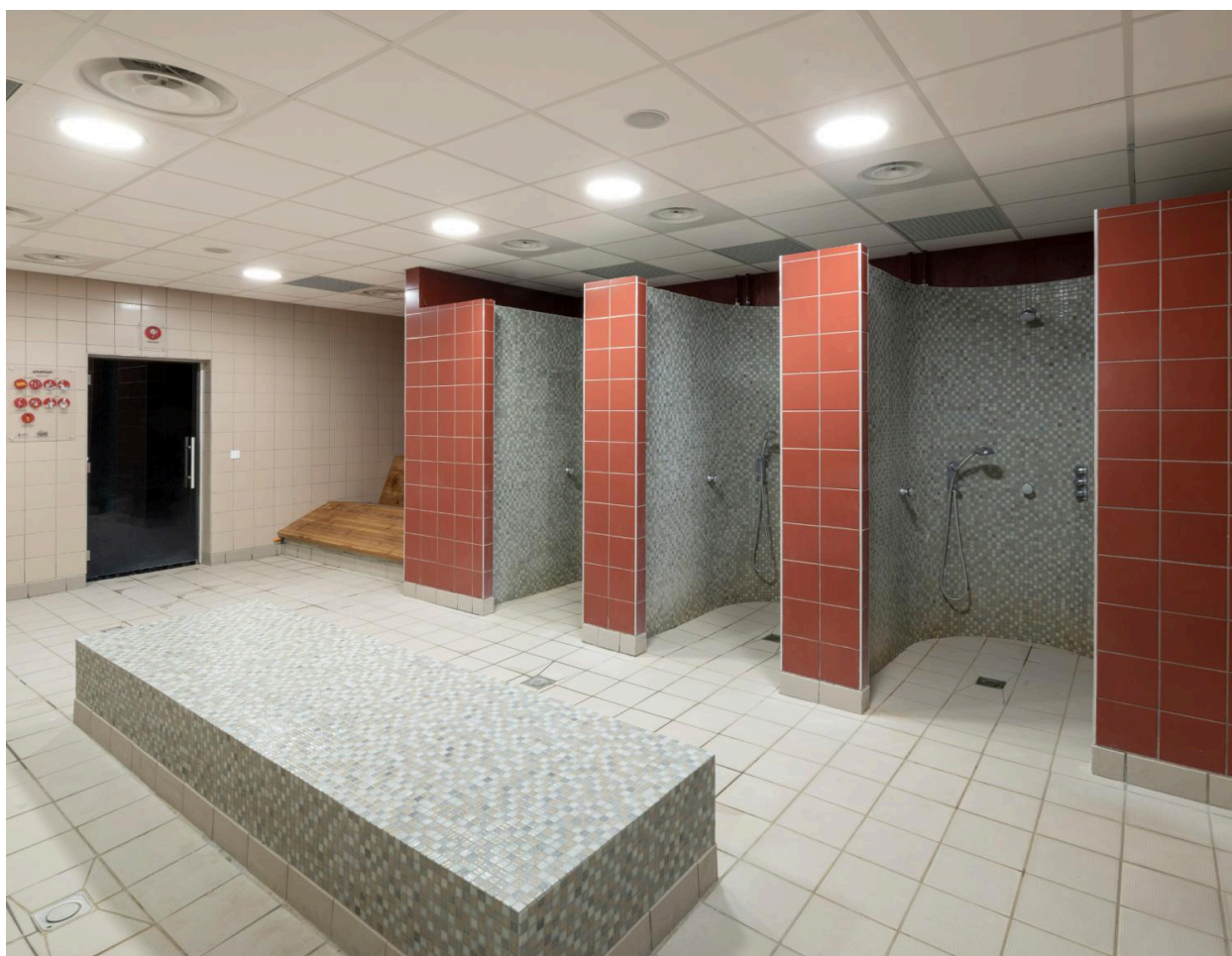
Vue intérieure de l'espace de repos entre le hammam et le sauna, premier sous-sol
