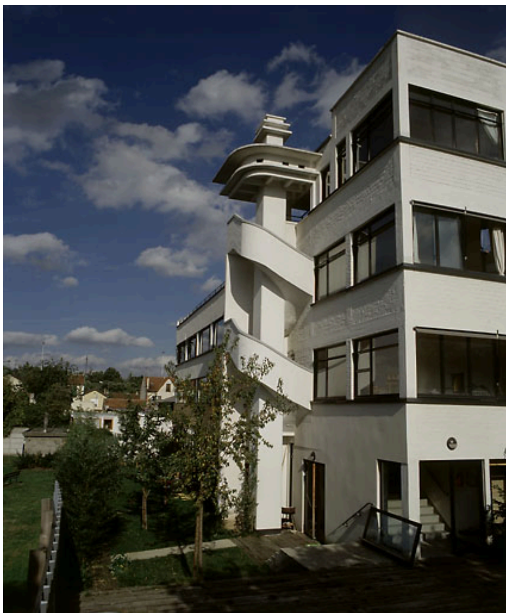
Vue de l'escalier extérieur.
