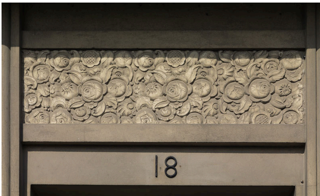
Détail du panneau de béton en bas-relief ornant le dessus du linteau de la porte d'entrée de l'immeuble
