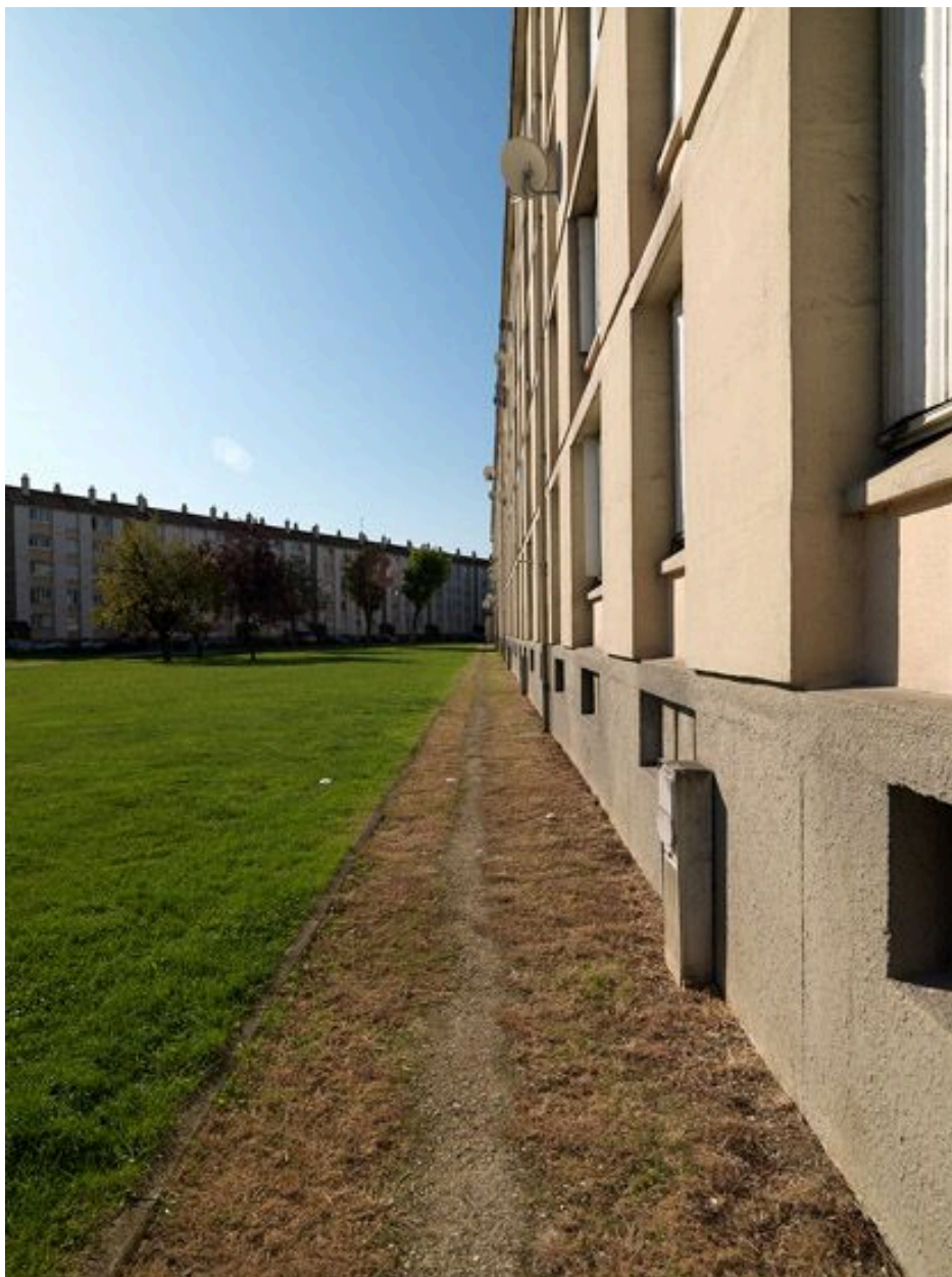
Villeneuve-Saint-Georges, cité dite cité Henri Sellier, rue Thimonnier, rue de Paris, avenue Winston-Churchill. Vue générale.
