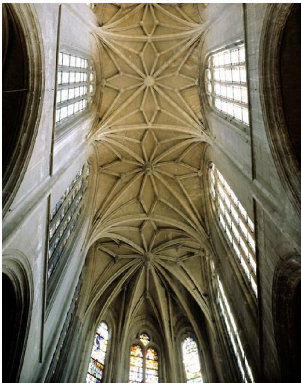
Vue intérieure de l'abside et du vaisseau central du choeur : voûtes et fenêtres hautes.
