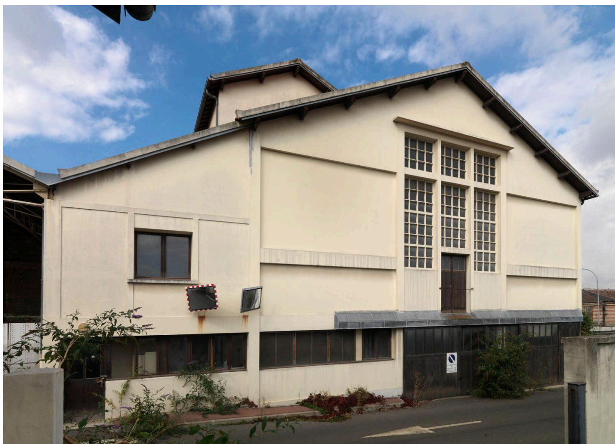
Site Biocitech. Vue des bâtiments désaffectés.
