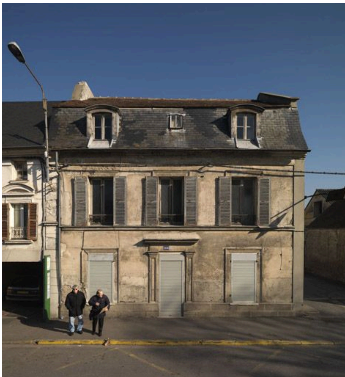
Vue d'ensemble de la maison.
