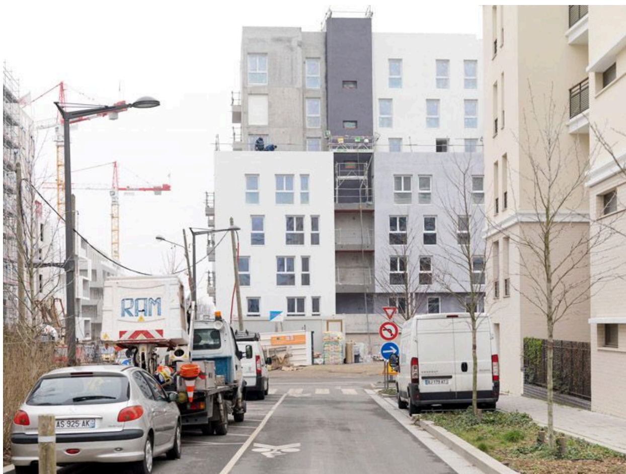
Massy. Quartier résidentiel Atlantis en construction.
