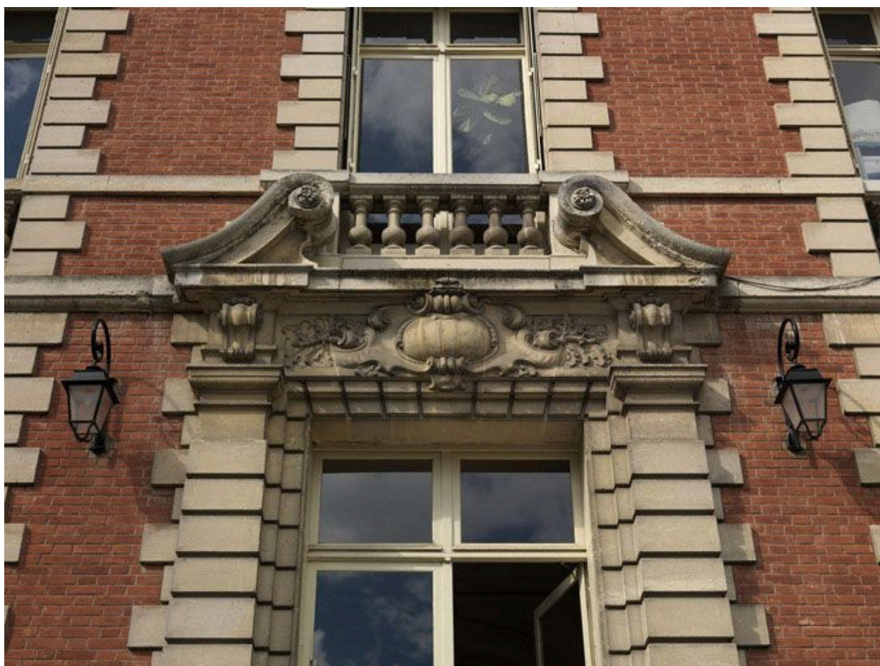
Vue du linteau de la porte et du garde-corps à balustres de la fenêtre du 1er étage.
