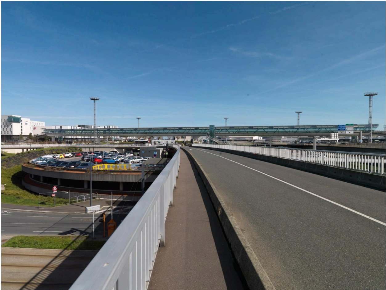
2018, la passerelle "cœur d'Orly" vue depuis l'ouest.
