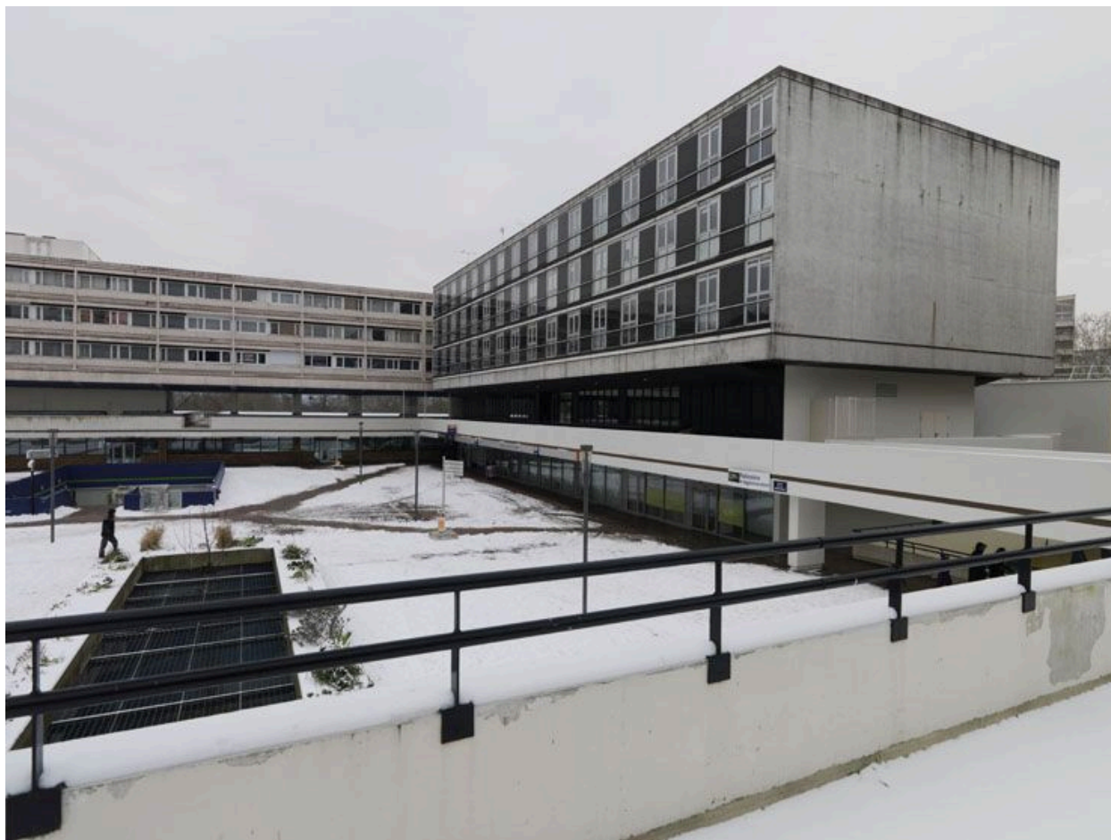
Vue d'ensemble des bâtiments de la piscine et du bureau.
