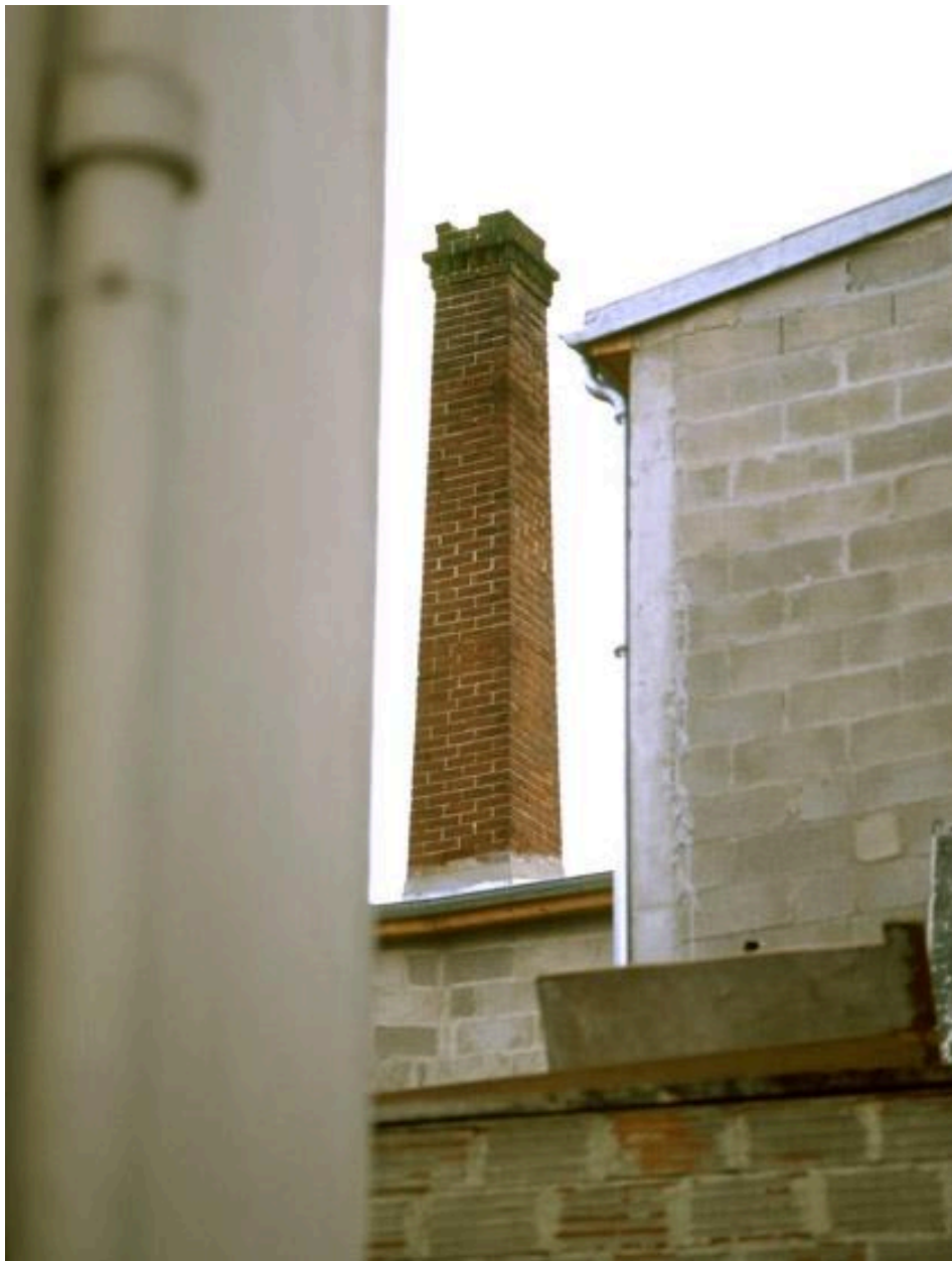
Vue de la cheminée en brique, depuis la rue Jean-Moulin.
