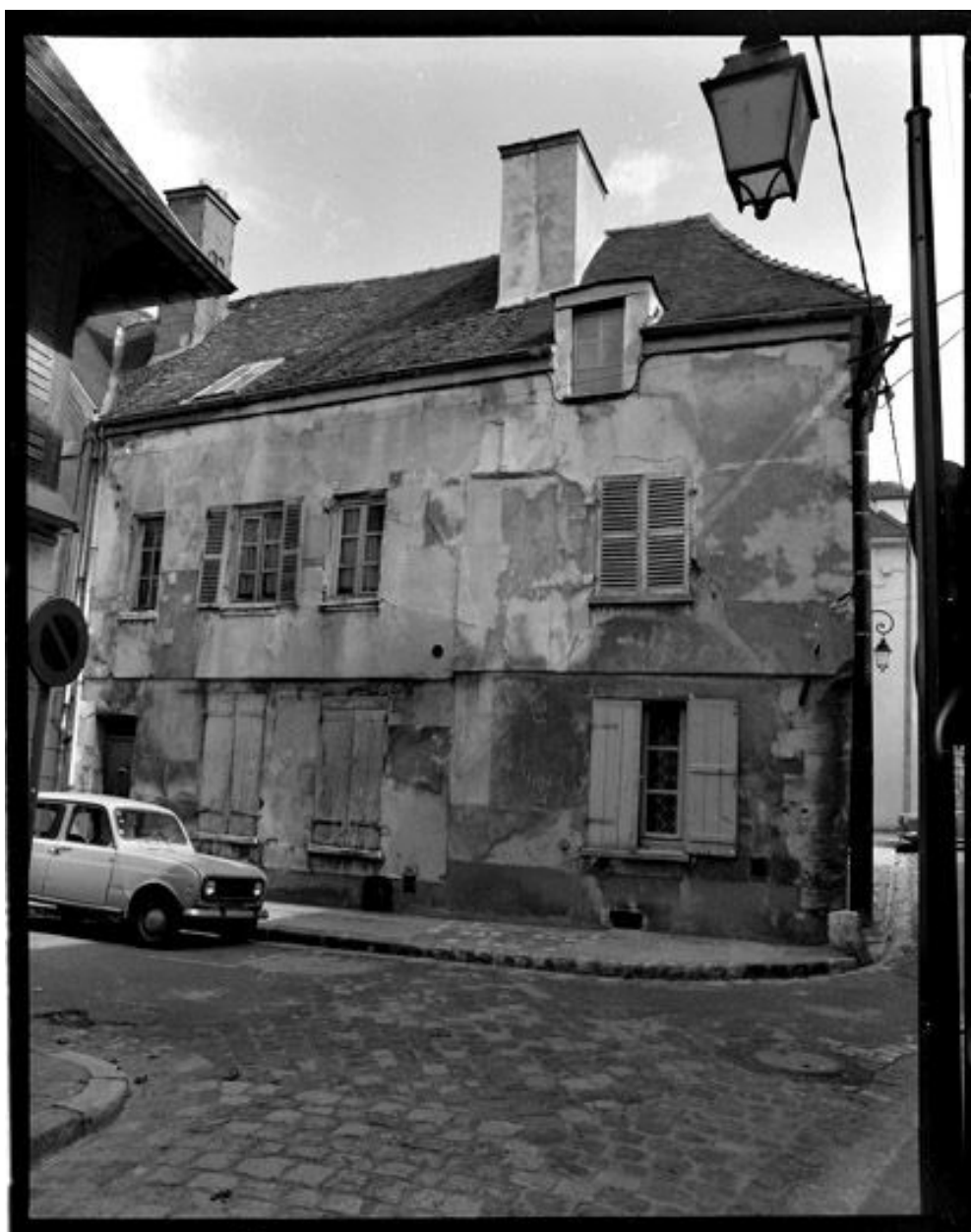
Maison, Cloître-Notre-Dame (rue du) 3. Vue de la façade sur rue.
