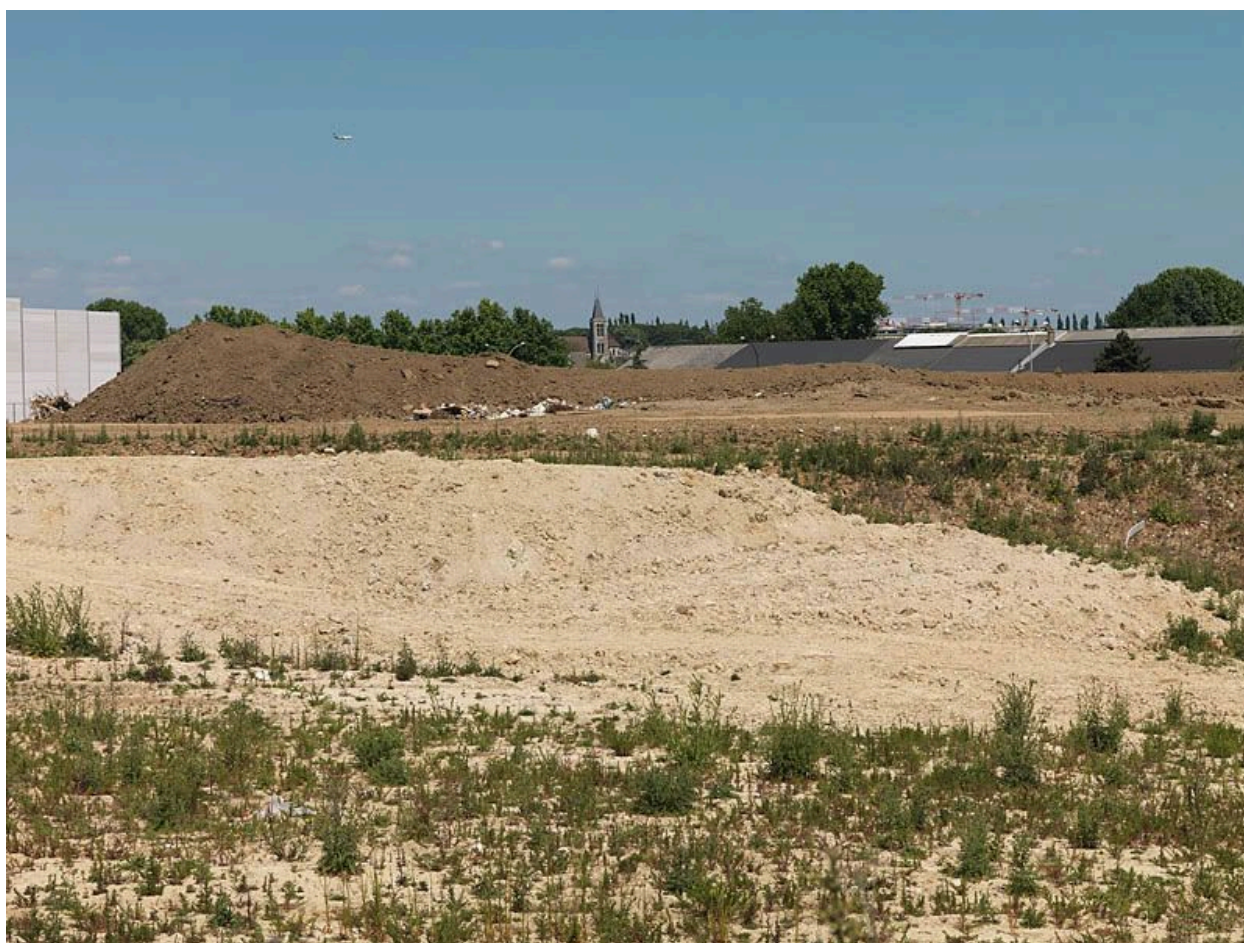
95, Gonesse, rue Nungesser et Coli. Entrepôts en constructions.
