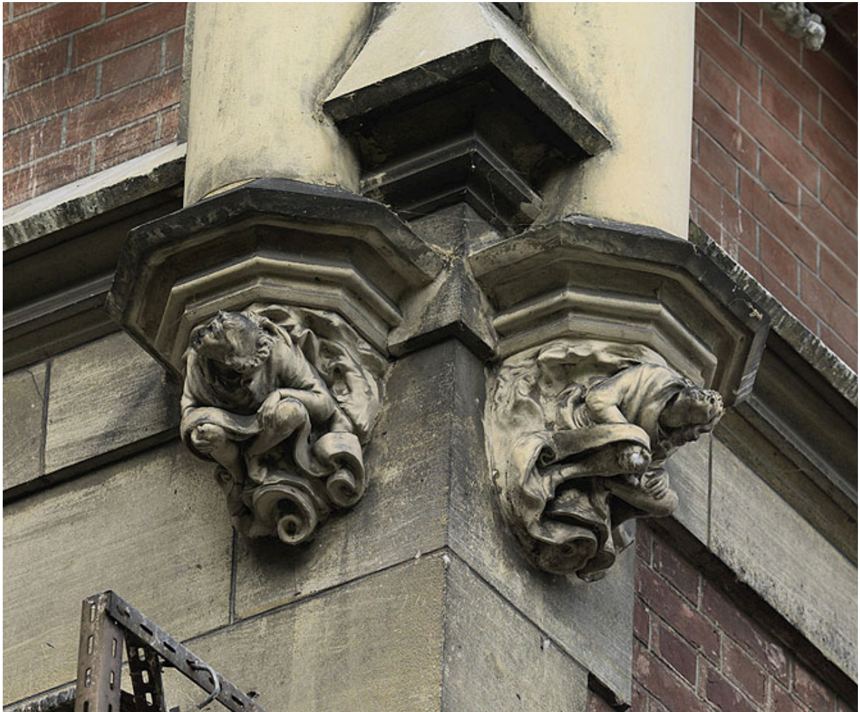
Détail des culots sculptés supportant les colonnettes ornant les parties hautes de la façade donnant sur le lac.
