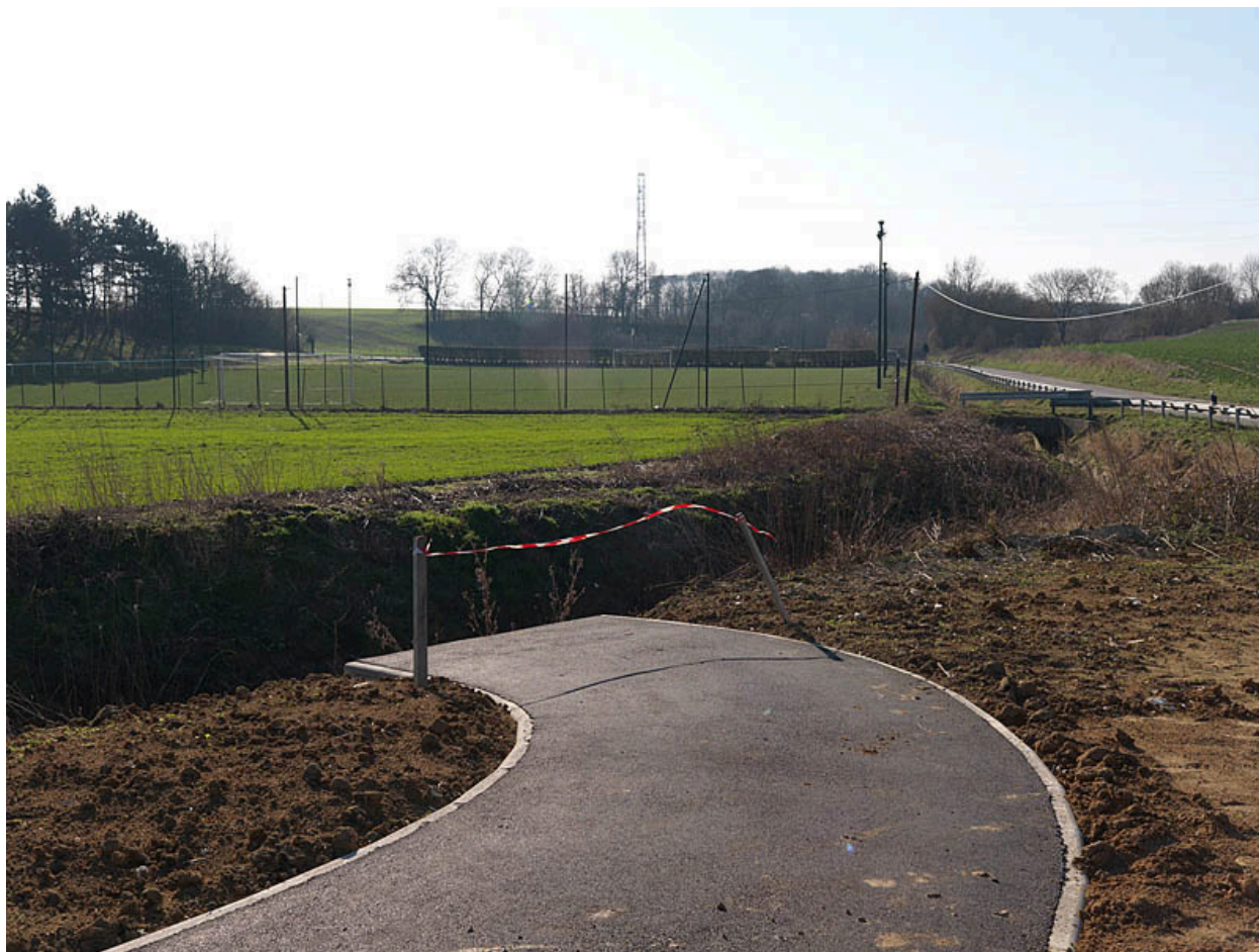
95, Vémars, Lieu-dit d'Orgeval. Une piste cyclable en cours de construction.
